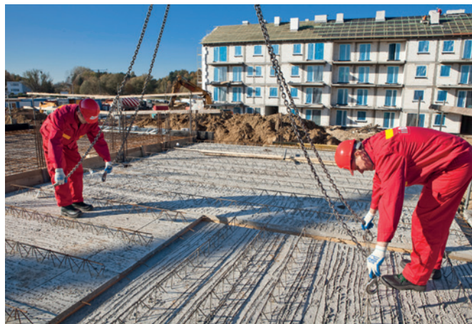
金银细丝板可实现快速和定制的楼板生产与安装
