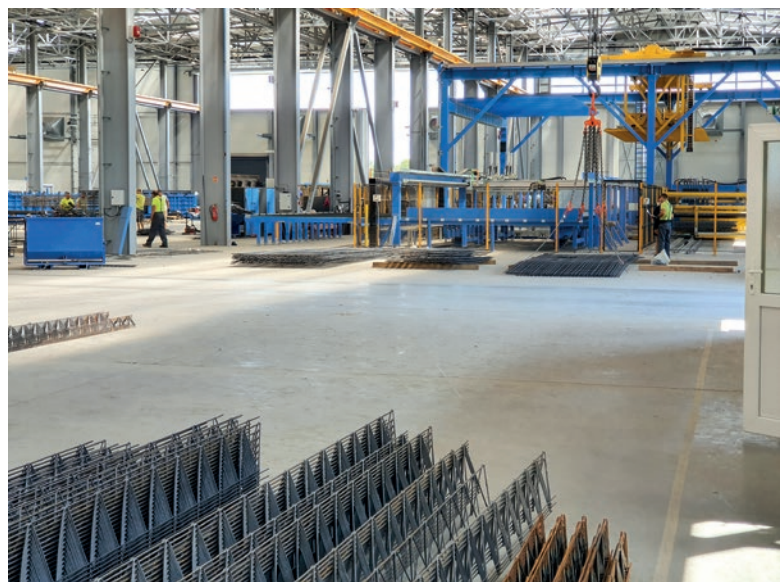
Hala produkcyjna ma powierzchnię 20 000 m 2 . Dzięki różnym stanowiskom roboczym możliwa jest jednoczesna praca na więcej niż jednym podkładzie.
