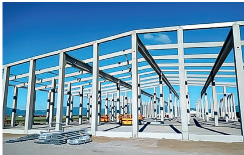
Dźwigary i słupy są produkowane w zakładzie, a następnie w wygodny i szybki sposób montowane na placu budowy.
