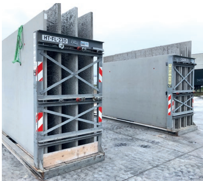
Ściany zespolone gotowe do wysyłki na plac budowy.
