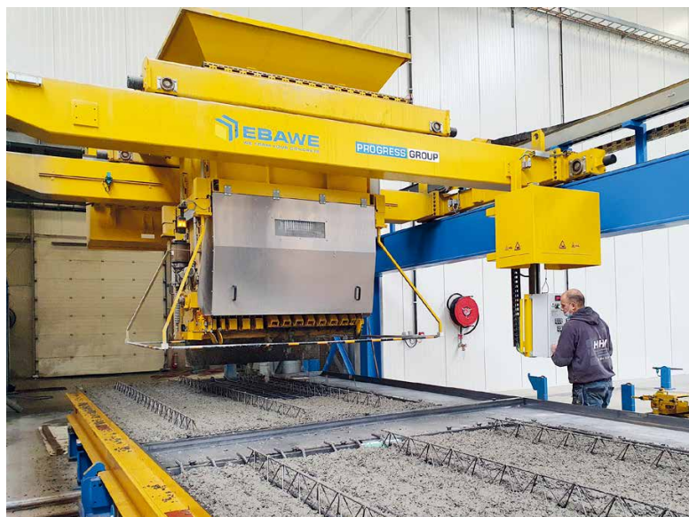
混凝土摊铺机将新鲜的混凝土分配到模板托盘中，用于测量已经到位的钢筋
