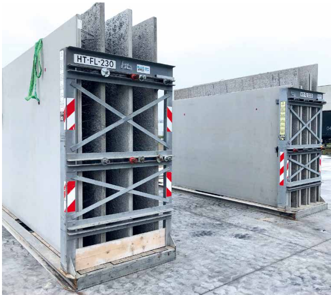
准备将双层墙运输到建筑工地
