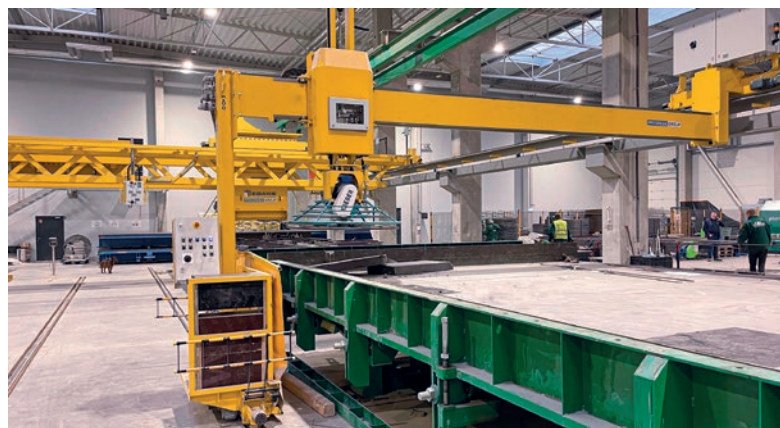
Po stwardnieniu powierzchni betonu kolejnym etapem jest jej dokładne wygładzenie przy pomocy elektrycznej zacieraczki.
