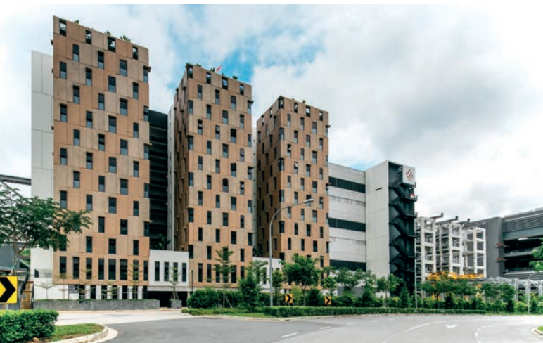
在 20000 平方米的建筑用地上，海峡建设集团建造了一座十二层的宿舍楼（前方）和一个四层附有高货架仓库的预制混凝土构件工厂
