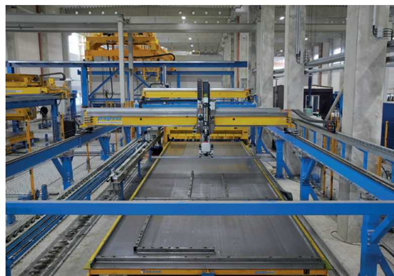
由 Progress Maschinen & Automation 公司出产的模板化与去模板化整合式机器人与 Infinity Line® 模板系统协同运作, 这能大幅缩减模板化所需的时间, 并确保生产出高品质的外部边缘结构
