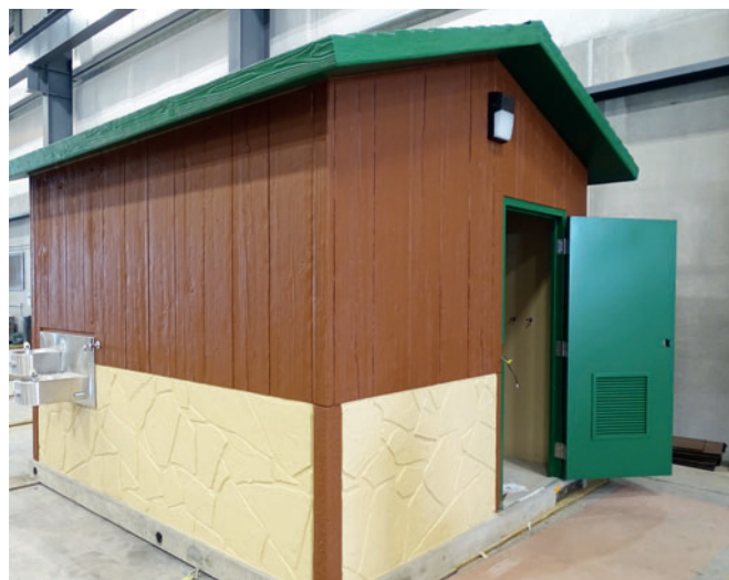
Huffcutt stellt Sanitärhäuser aus massiven Betonelementen her und baut diese direkt im Werk zusammen, bereits komplettiert mit sämtlichen Sanitäranlagen. Gestaltet werden die kleinen Gebäude in architektonischen Designs mit Farbbeton und Matrizen in Fliesen-, Stein- und Holzoptik.
