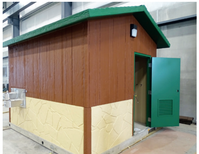
Huffcutt 使用实心混凝土构件制造厕所，并直接在工厂内组装，已经尽数配备了卫生设施。这些小建筑的建筑设计采用了彩色混凝土和模衬以呈现出瓷砖、石头和木材的视觉效果
