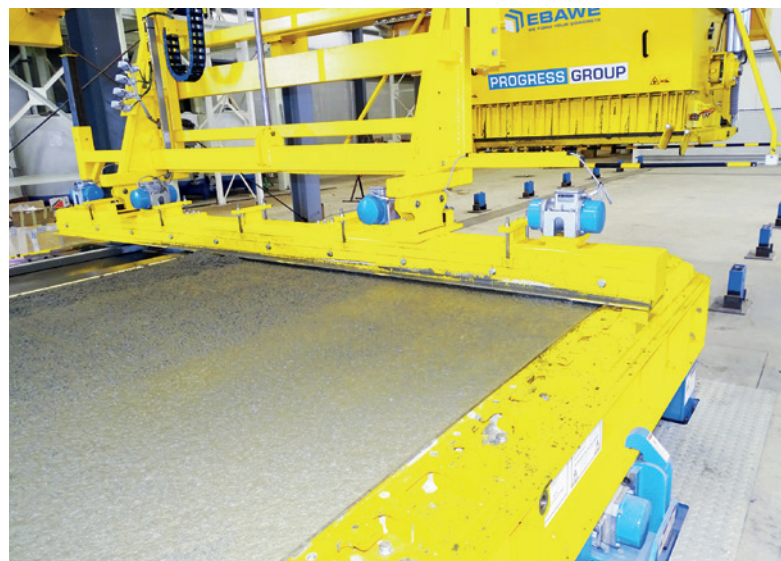
连接在混凝土摊铺机上的整平梁将混凝土抽离，并根据混凝土层的深度将其压实
