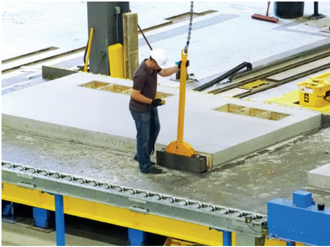
模板机器人大大提高了生产的自动化程度。在处理转横装置的帮助下，手动拆卸模板
