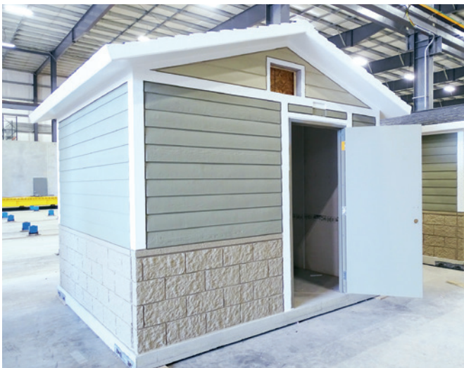
Huffcutt 使用实心混凝土构件制造厕所，并直接在工厂内组装，已经尽数配备了卫生设施。这些小建筑的建筑设计采用了彩色混凝土和模衬以呈现出瓷砖、石头和木材的视觉效果
