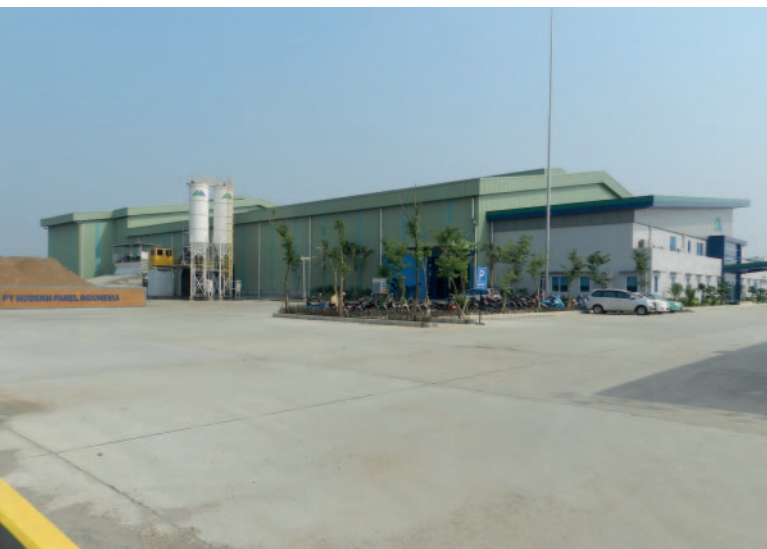
Kürzlich eröffnete PT Modern Panel Indonesia sein erstes Betonfertigteilwerk im neuen Industriegebiet von Cinkande, Banten.
