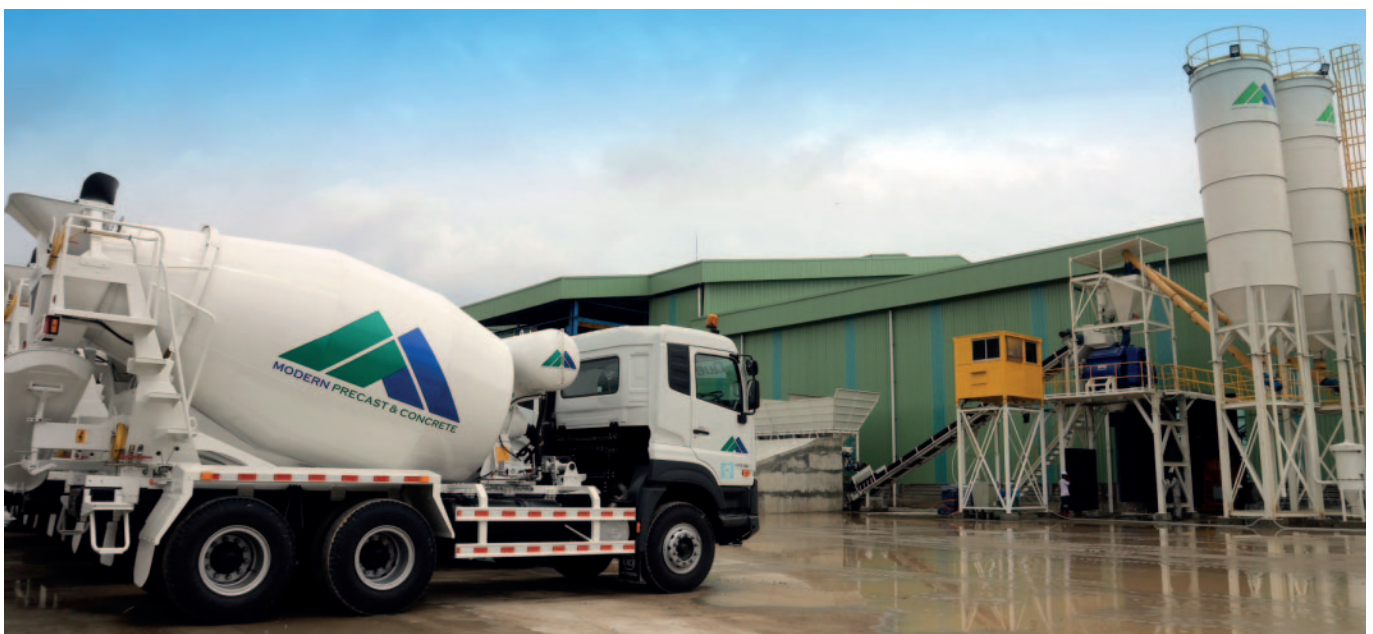
Die neue Mischanlage hat eine Kapazität von 500 m 3 pro Schicht. Modern Precast hat derzeit sechs Fahrmischer mit je 7 m 3 im Einsatz.
