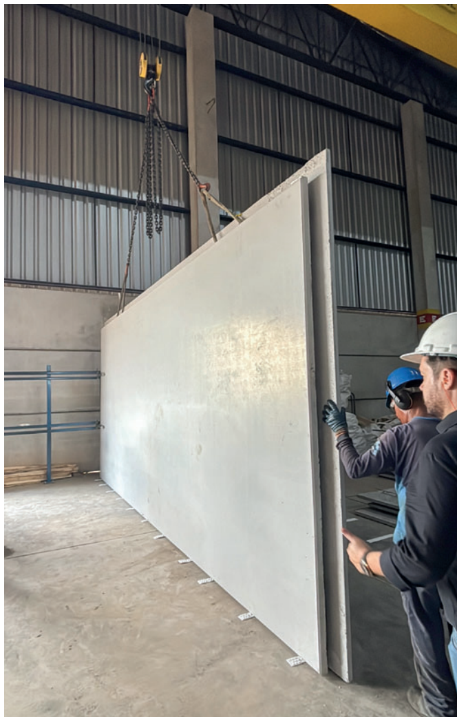
Новое поворотное устройство на заводе сборного железобетона под Сан-Паулу позволяет выпускать двойные стеновые панели с безупречной фактурной поверхностью бетона
