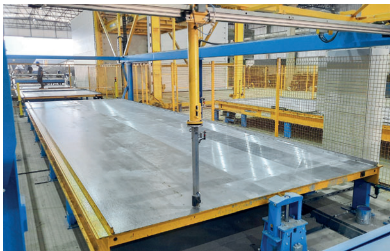
Плоттер с высокой точностью наносит контуры будущего бетонного элемента на поверхность поддона
