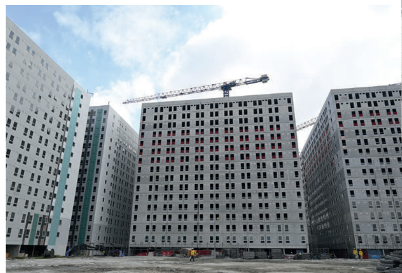
Erschwinglicher 14-stöckiger Wohnbau aus 90 % Fertigteilen
