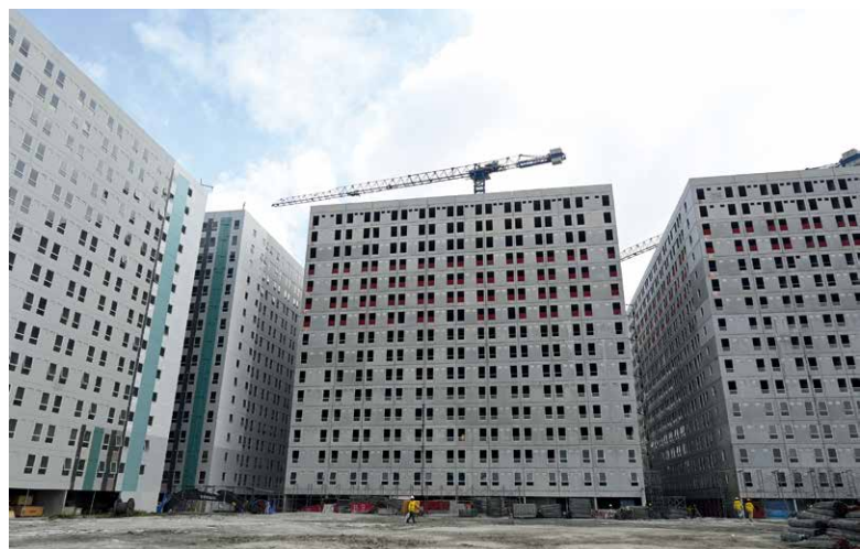
14 层高的中层经济适用房，所用建筑材料的 90% 都为预制构件
