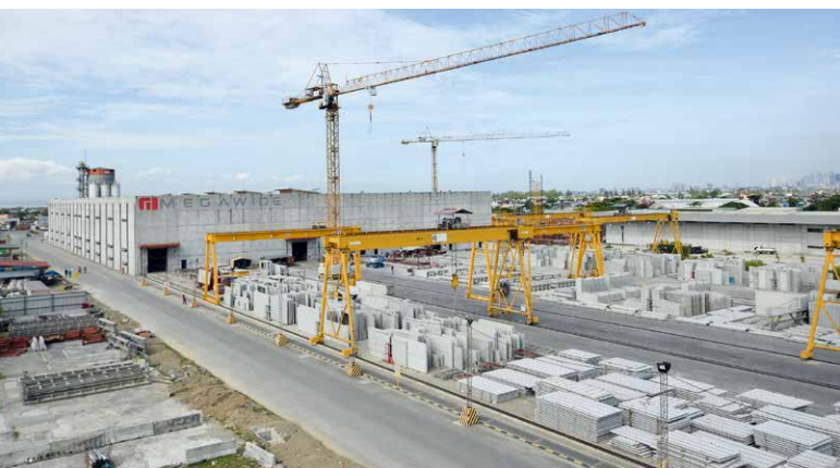
在工厂生产预制混凝土构件会显著减少现场建造所需的时间，也能保证墙体和板材的质量始终保持在高水准
