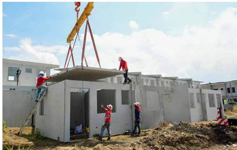
根据规范要求的最低标准，项目房屋两层之间应使用厚度不低于 100mm 的预制实心墙。而使用的每块实心板的厚度不应小于 120mm
