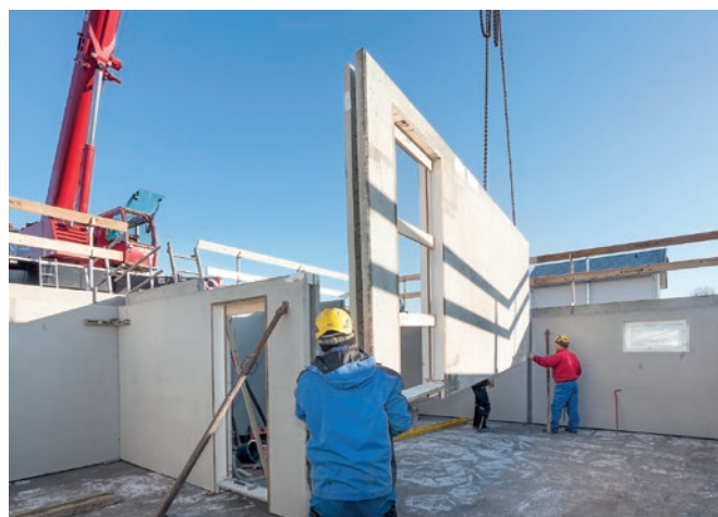
Montaż piwnic Schwörer – podstawy prefabrykowanych domów firmy Schwörer.
