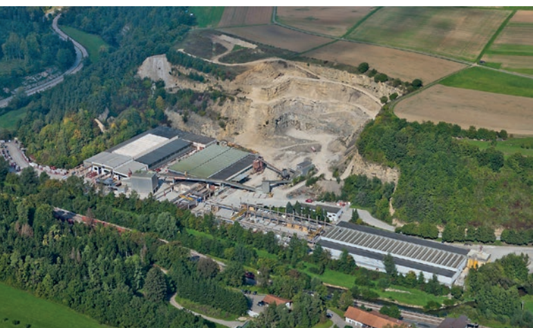
Zakład firmy Schwörer Bausysteme GmbH w Haigerloch-Stetten.
