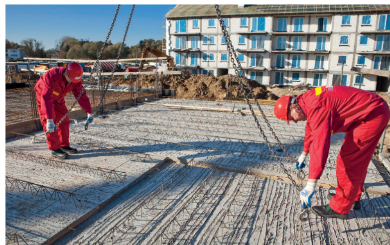
Płyty stropowe typu filigran zapewniają szybkie tempo produkcji i montażu zindywidualizowanych stropów.
