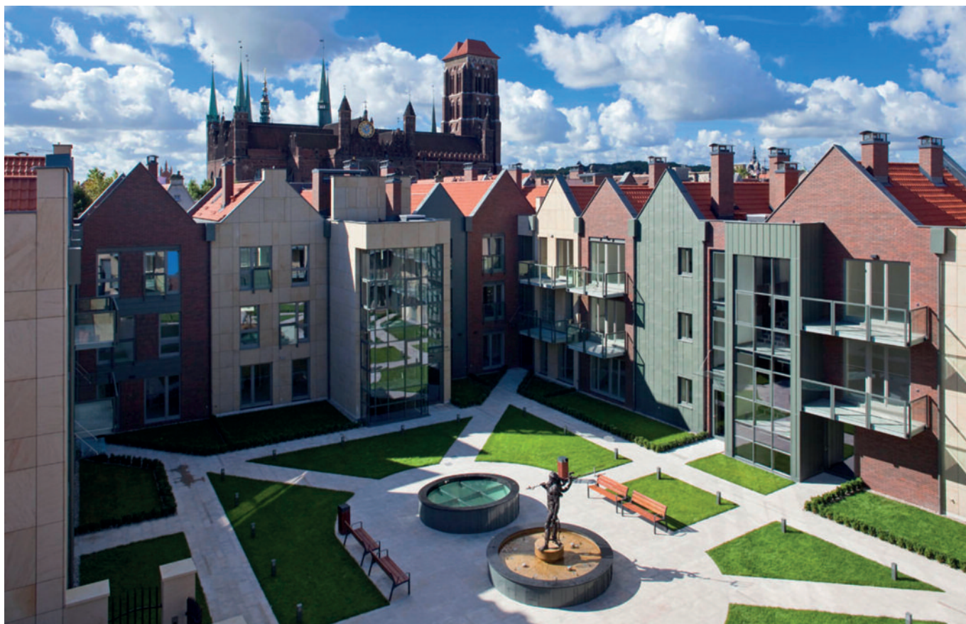
Podczas realizacji projektu Kwartal Kamienic firma inBet wykorzystała liczne prefabrykowane elementy betonowe.
