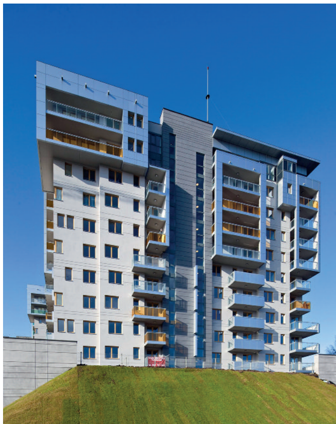
Dzięki zastosowaniu prefabrykowanych elementów betonowych skraca się czas budowy osiedli mieszkaniowych, takich jak np. City Park.
