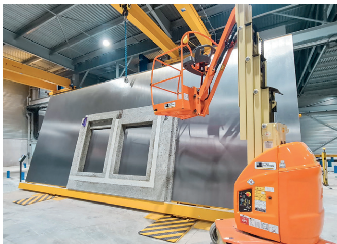
新厂房内的倾斜设备将成品墙板调整为垂直方位，实现安全便捷的构件脱模操作
