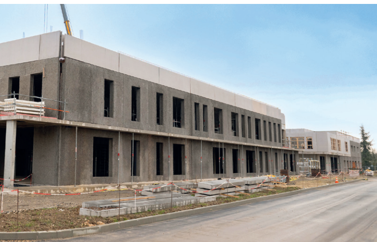
图尔 Bouygues 医院项目成功应用木混凝土墙板、低碳双墙及 Isopré 保温墙系统
