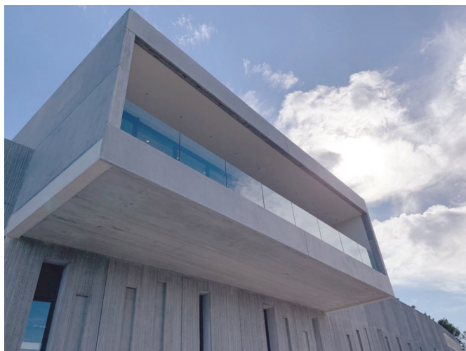
普罗旺斯圣雷米的 Métifiot 酒窖采用 Spurgin 矩阵构造双墙技术完美落成
