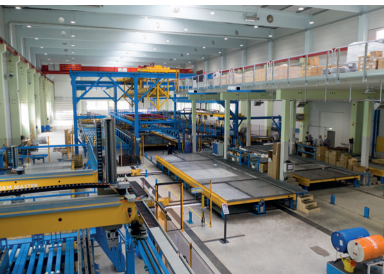
Nowa, wysoce zautomatyzowana linia obiegowa w zakładzie prefabrykacji betonu firmy Eder w Kallham.
